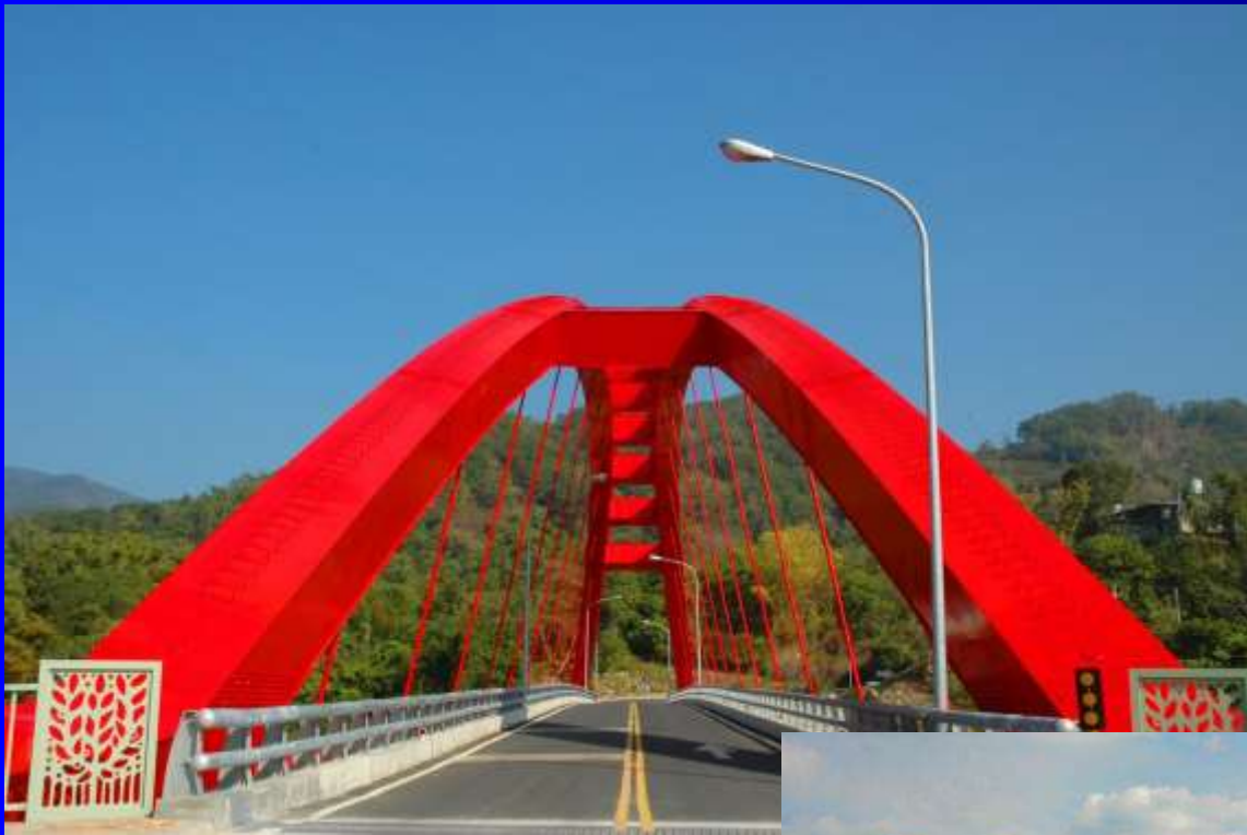
六龜東溪大橋
