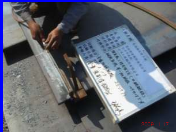
鋼板材料查驗、取樣
