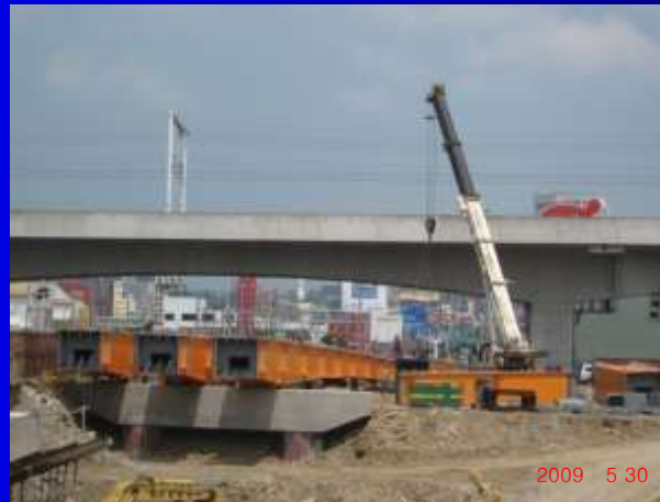
現場吊裝組立作業
