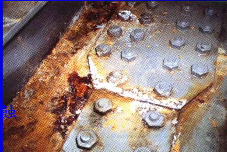
鋼梁表面塗膜劣化，孔蝕
