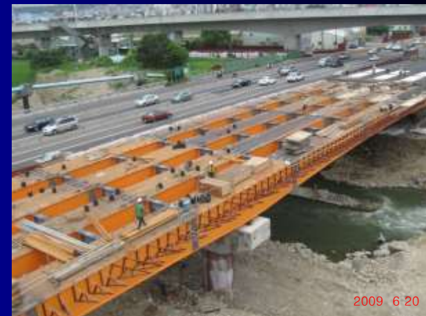
鋼梁吊裝完成
