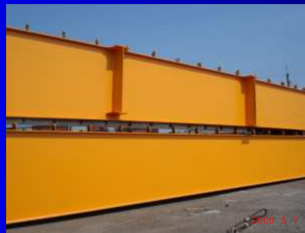
面漆塗裝完成
