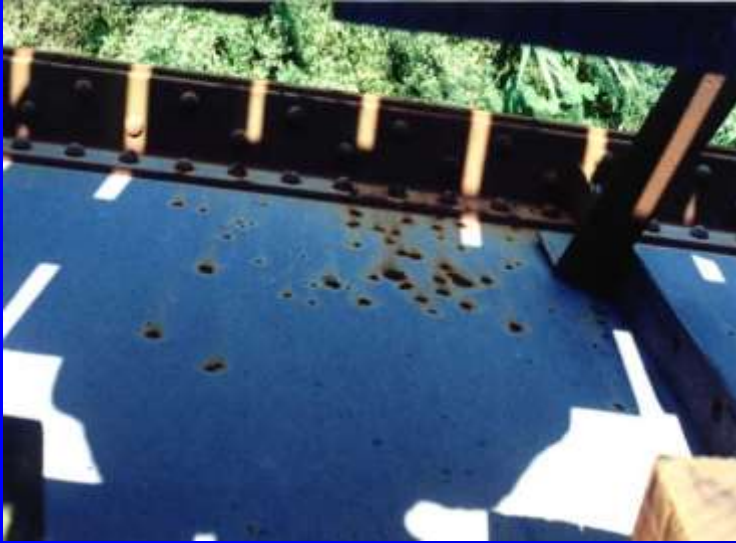
鋼梁表面塗膜劣化，孔蝕
