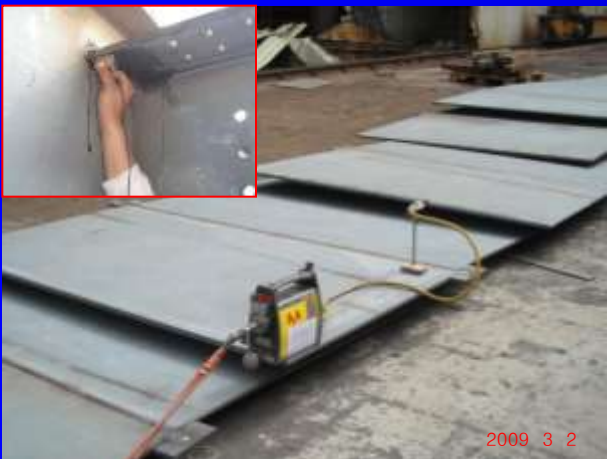
NDT(RT、UT銲道檢測)
