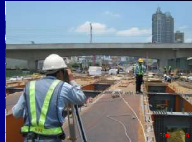
鋼梁拱度、高程檢測
