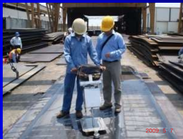
鋼板材料夾層檢測
