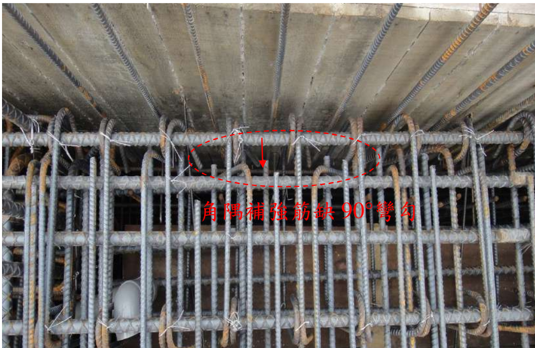
圖 2-19、角隅補強筋缺 90° 彎勾
