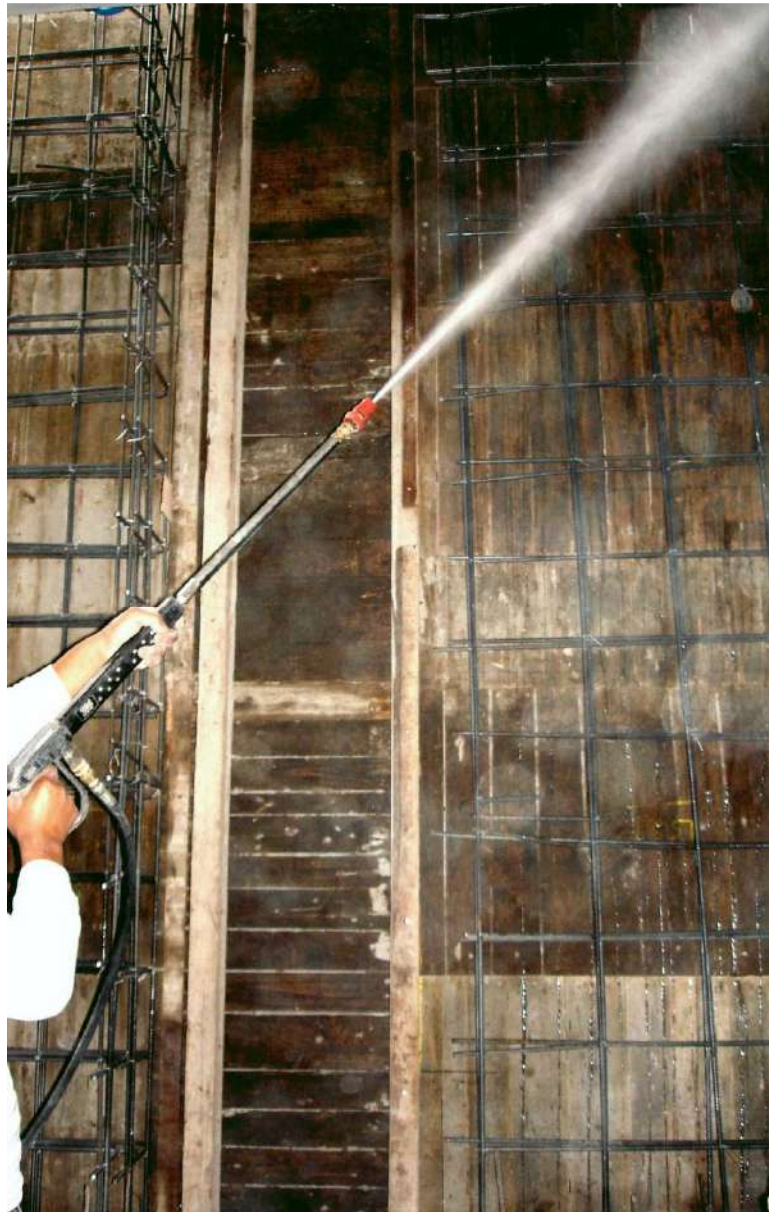
圖 2-8、高壓水柱清洗模板土渣
