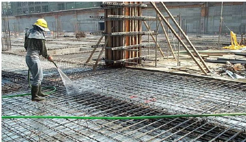
圖 2-10、水柱沖洗柱梁牆底雜物
