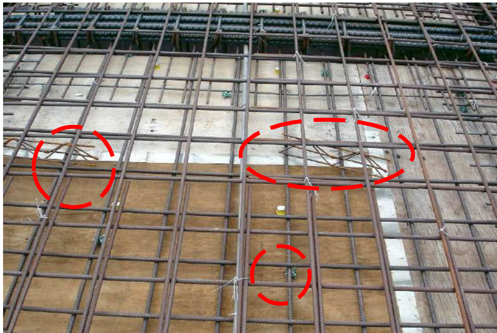
圖 2-37、塑膠墊塊與 K 支架
