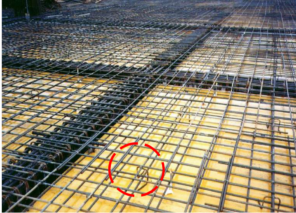
圖 2-36、樓版頂層筋使用 U 型墊筋
