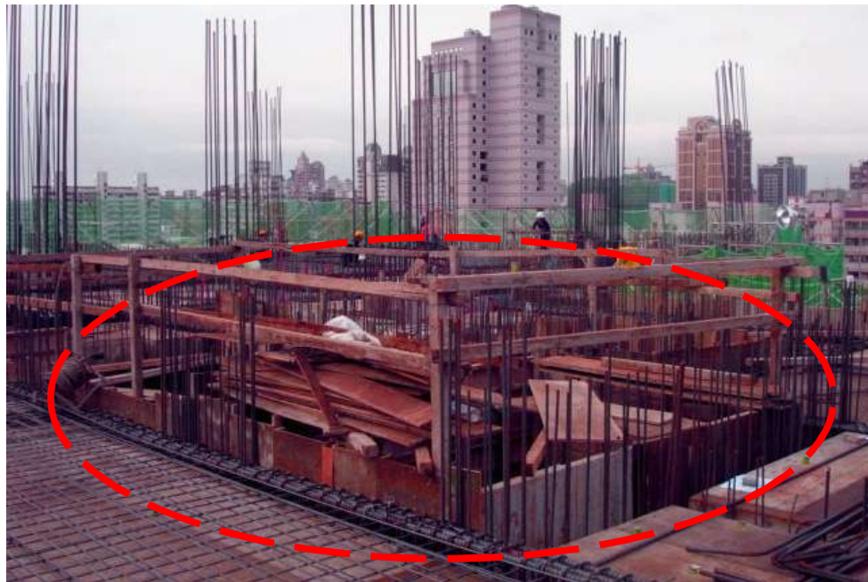
圖 2-42、施工樓層的平面開口四周設置欄杆
