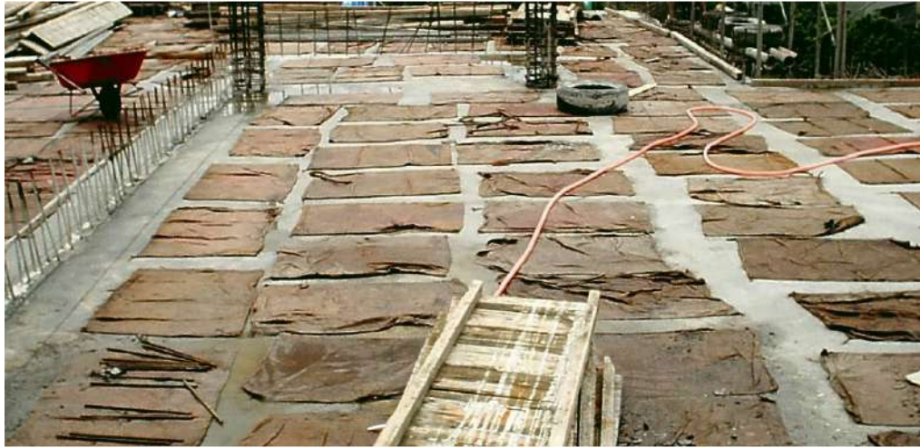
圖 2-13、混凝土澆置完成，於 4 小時內鋪置麻布袋後澆水養護
