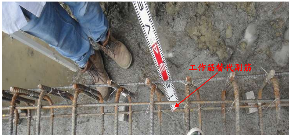
圖 2-16、工作筋替代副筋
