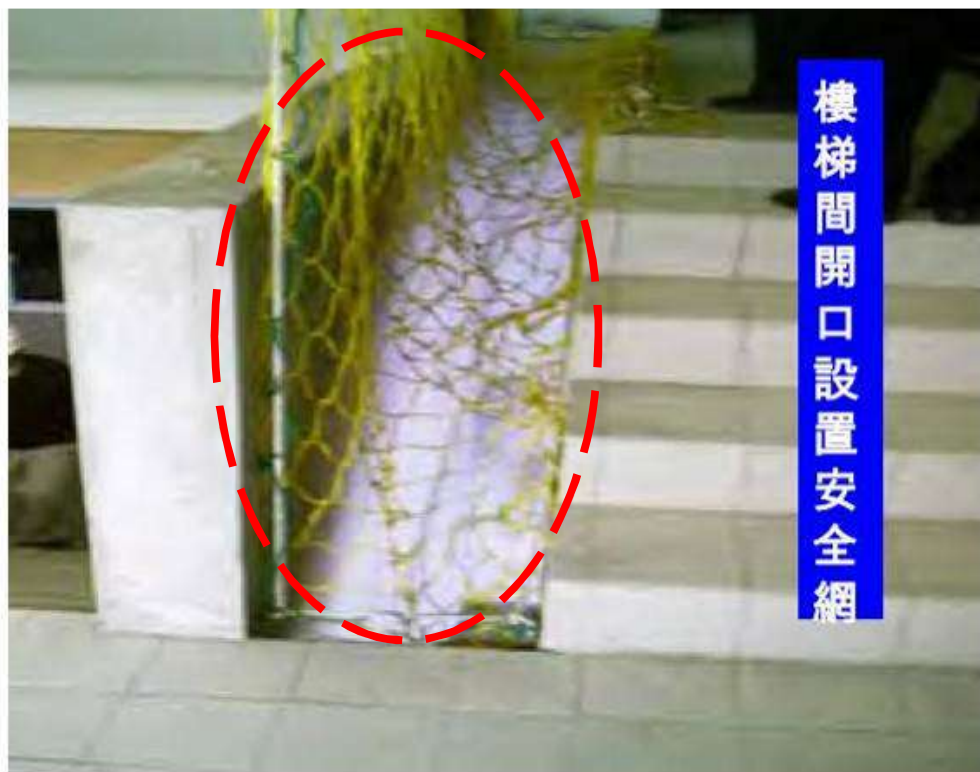
圖 2-46、樓梯開口設置安全網
