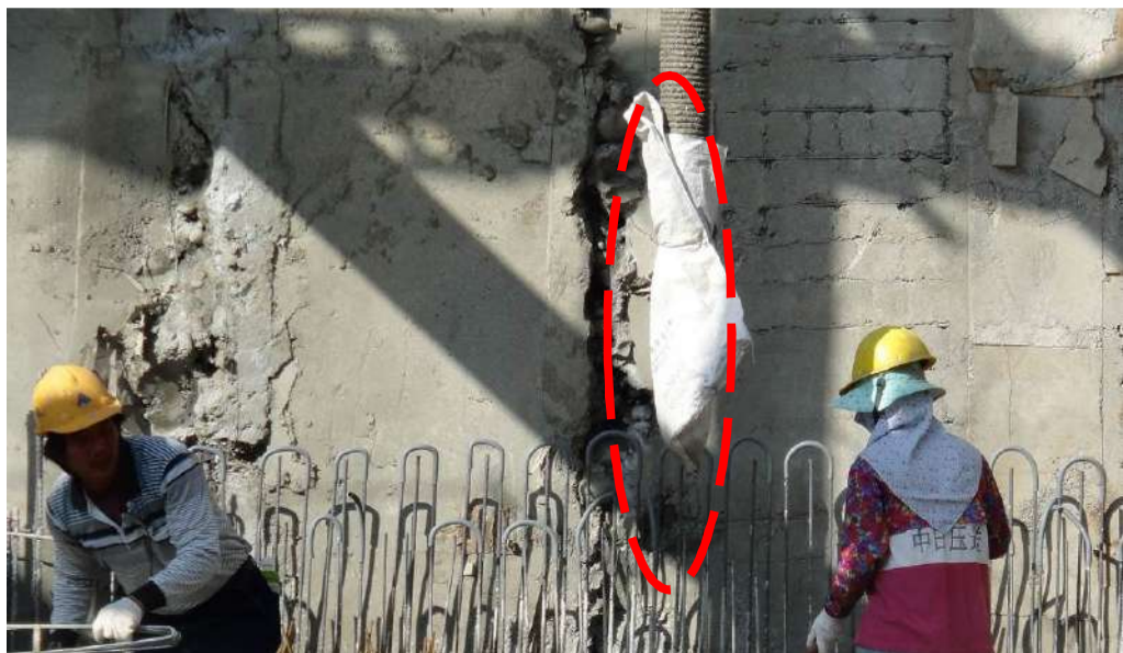
圖 2-12、出漿口用 PE 袋包裹，次用 PE 袋回收砂漿料
