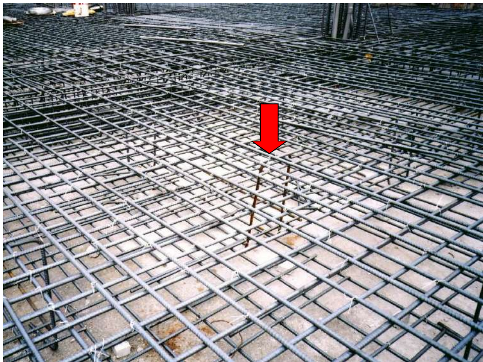
圖 2-35、F.S.上下層筋用U型鐵件隔開
