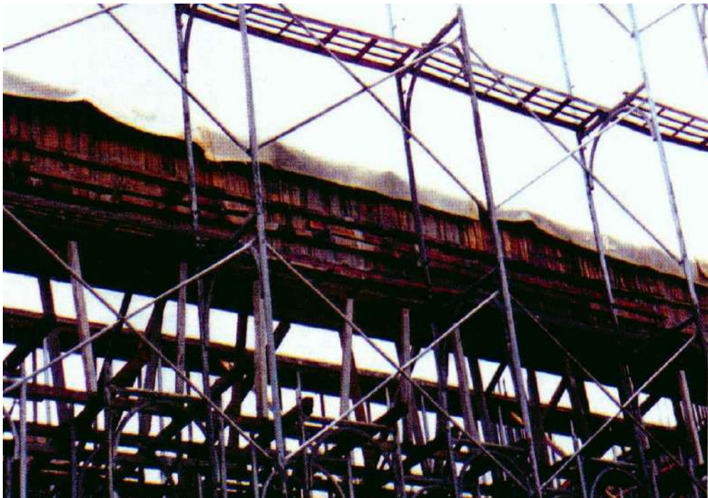
圖 2-14、大梁混凝土持續灑水養護
