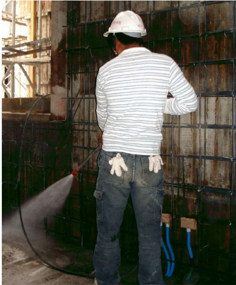
圖 2-9、高壓水柱清洗清洗柱牆底雜棄物
