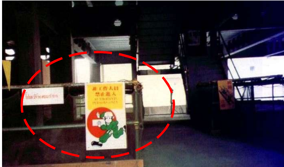
圖 2-43、欄杆上貼警示標語
