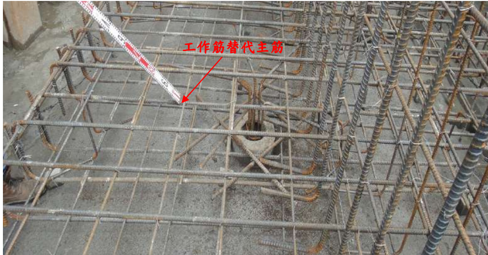
圖 2-15、工作筋替代主筋
