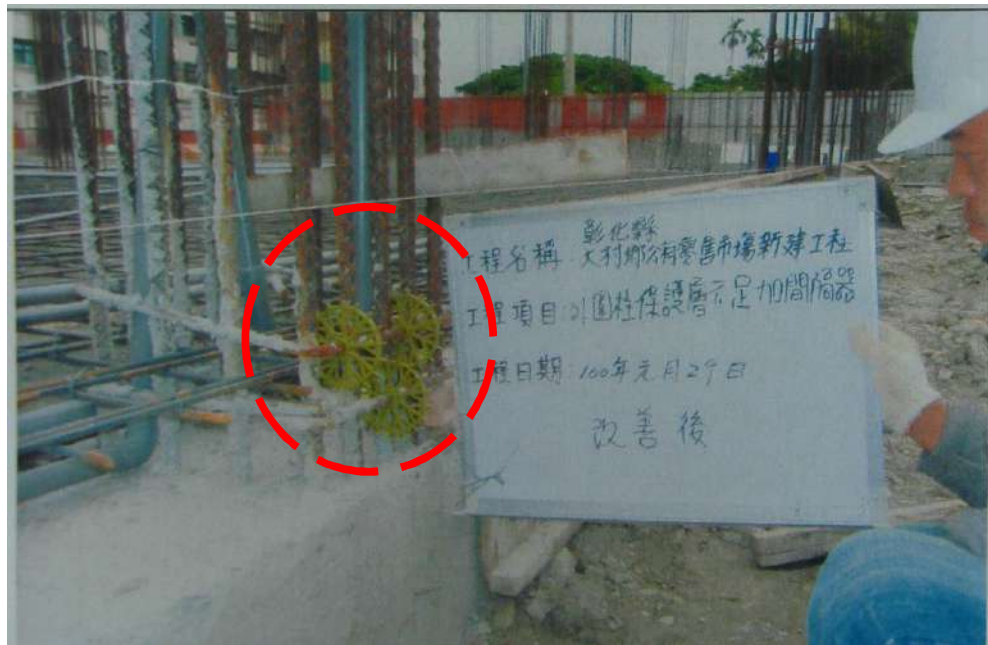
圖 2-33、柱筋保護層確保 4cm
