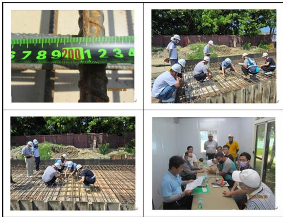
南分圳(埔崙里)新建箱涵工程停留點抽檢
