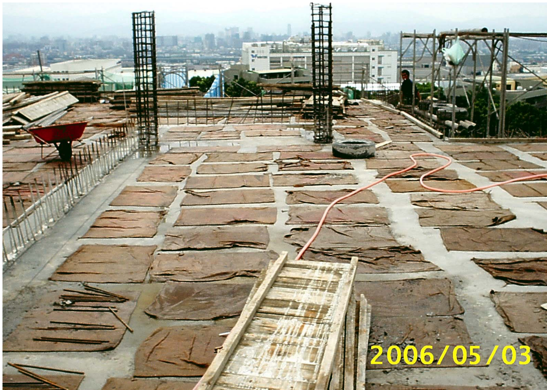
樓版混凝土覆蓋麻布袋養護
