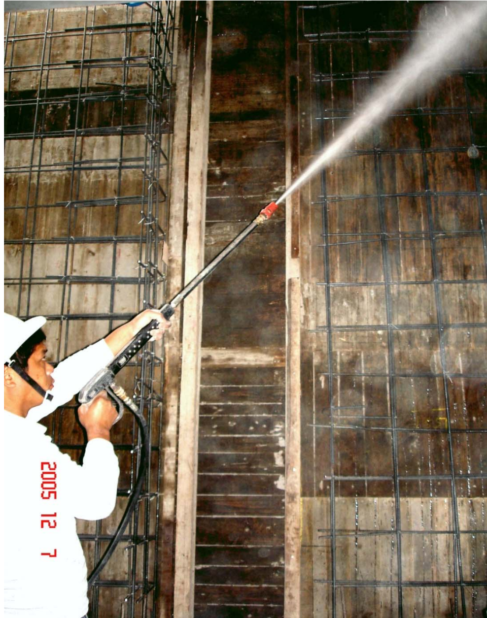
高壓水柱清洗模板土渣
