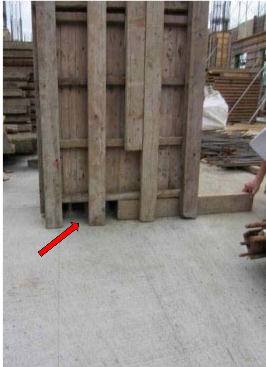
柱底預留清潔口
