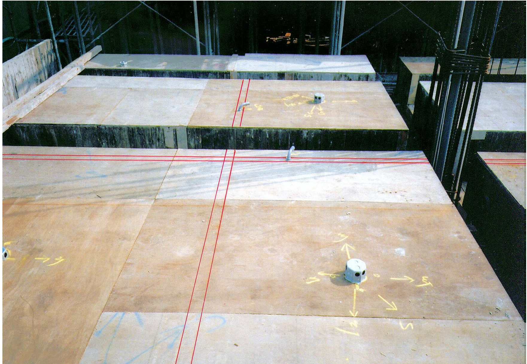
樓版配管放樣
