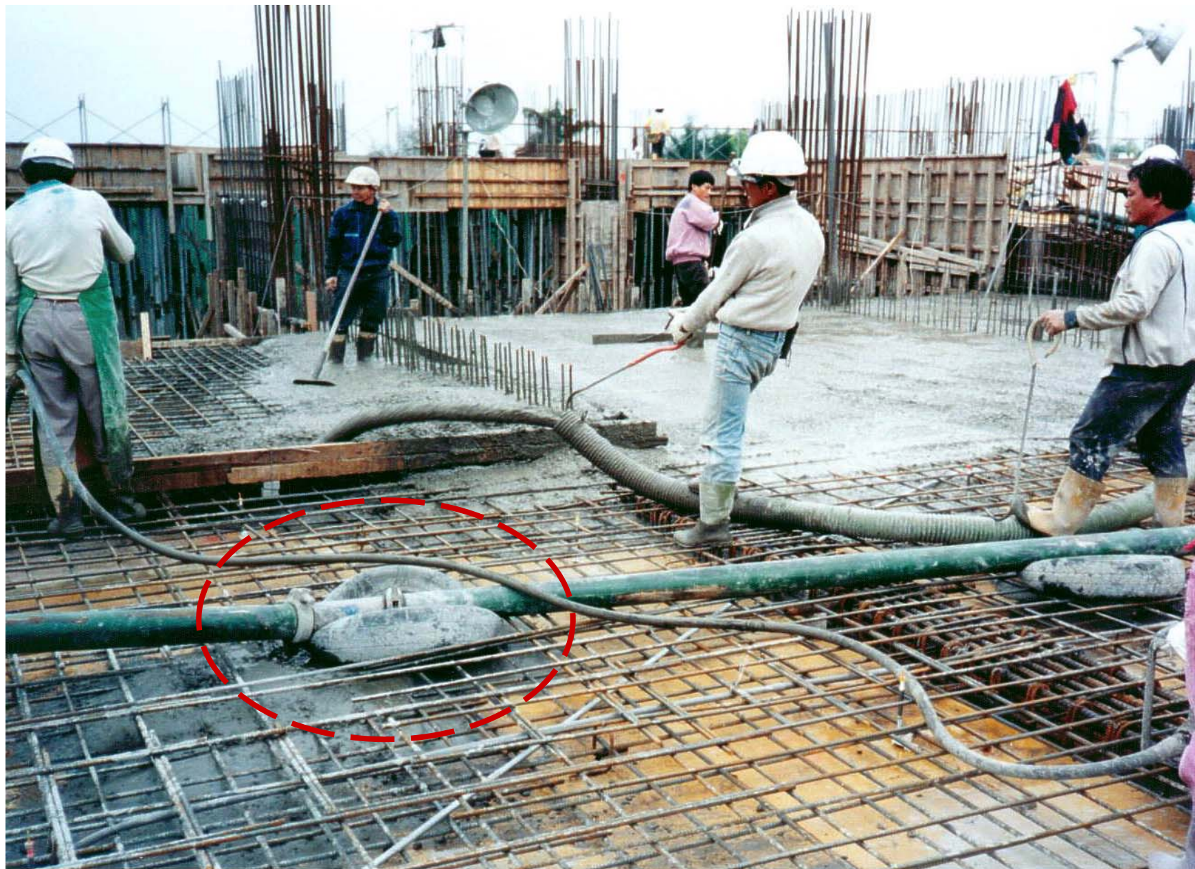
樓版鋼筋與壓送管間用輪胎隔墊
