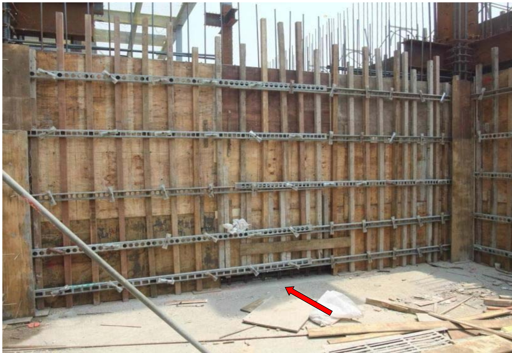
地下室外牆牆底預留清潔口
