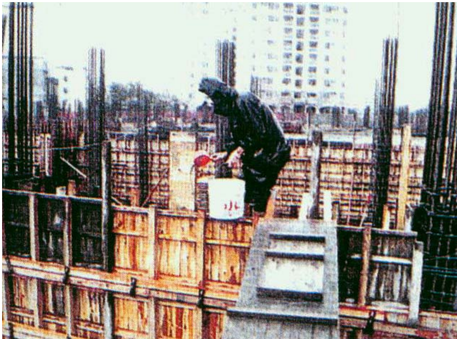
在續接處於搗築混凝土前潑水泥漿
